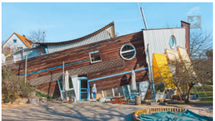
15 Stuttgart-Untertürkheim, Kindergarten Luginsland.
